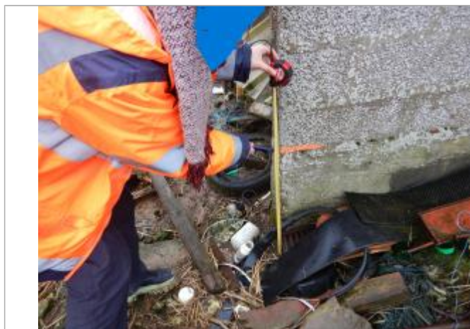
Le repère est un mur en parpaing.
