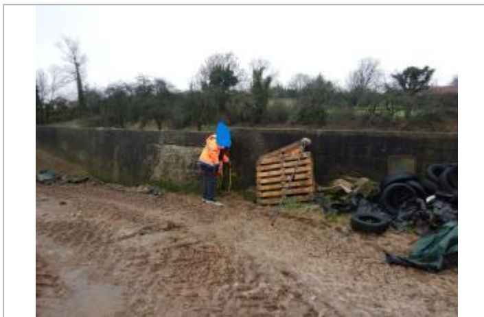
Le site est un mur en parpaing.
