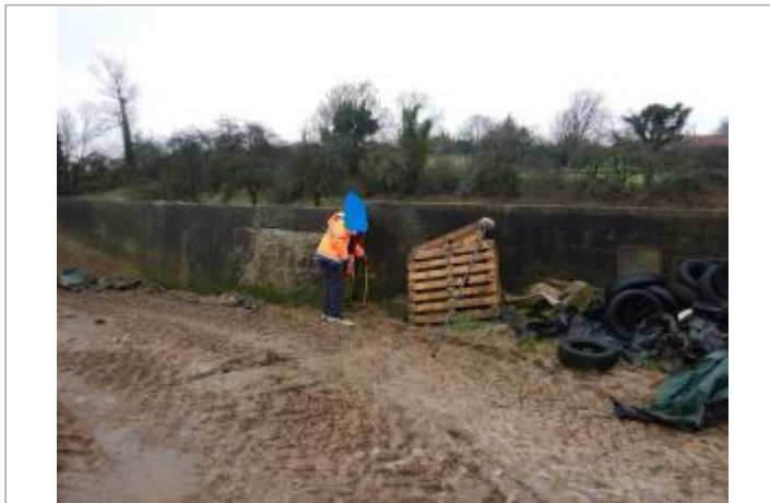
Le site est un mur en parpaing.
