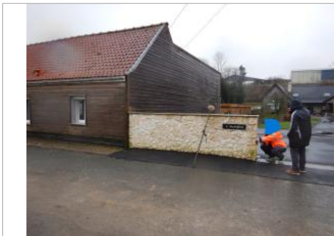
Le site est une clôture de base en pierre.
