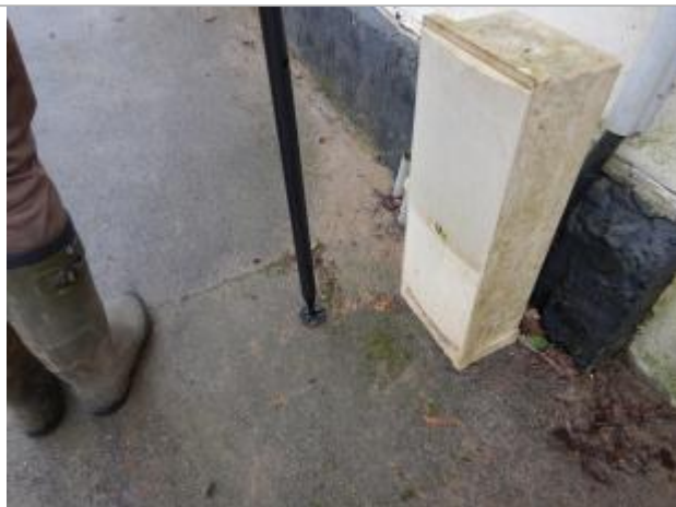
Le repère est à même le sol.
