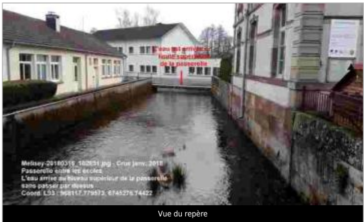
Melisey-20180315_182831.jpg - Crue Janv. 2018 Passerelle entre les écoles L'eau arrive au niveau supérieur de la passerelle sans passer par dessus Coord. L93 : 968117.779573 ; 6745276.74422 Vue du repère
