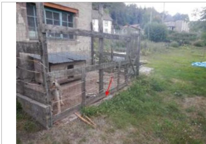
Vue du site
