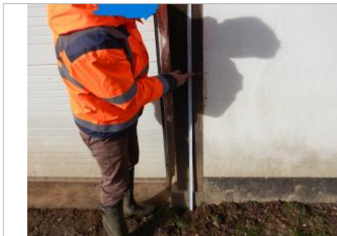
Le repère est localisé sur un poteau en bois.
