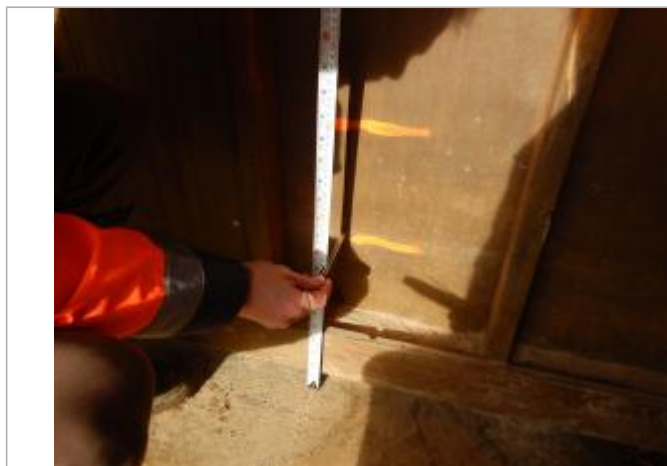
Le repère est situé sur le mur d'une cahute en bois.
