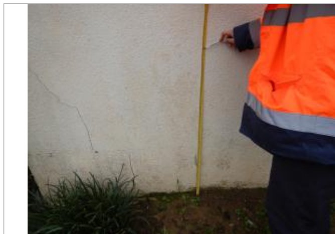
Le repère est sur le mur d'un maison privée.
