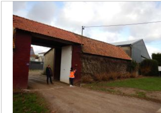
Le site est un poteau en brique rouge
