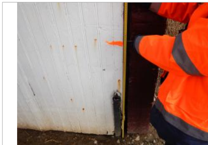
Le repère est au pied d'un poteau en brique.
