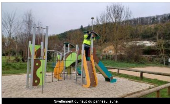
Nivellement du haut du panneau jaune.
