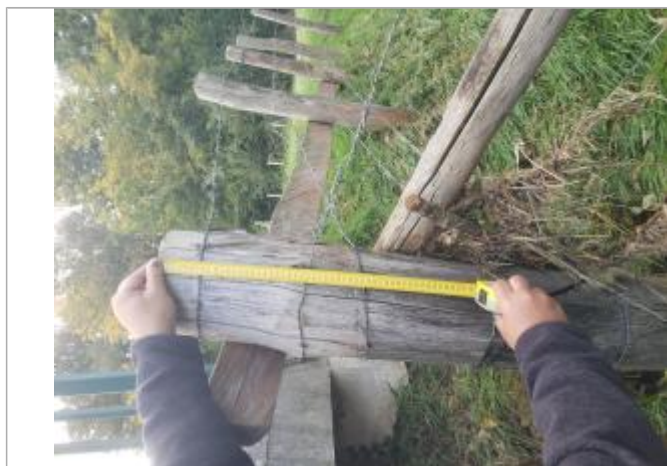
relevé de la hauteur de la laisse par rapport au haut du poteau (-40 cm avec précision de +/- 5 cm)
