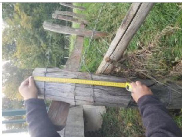
relevé de la hauteur de la laisse par rapport au haut du poteau (-40 cm avec précision de +/- 5 cm)
