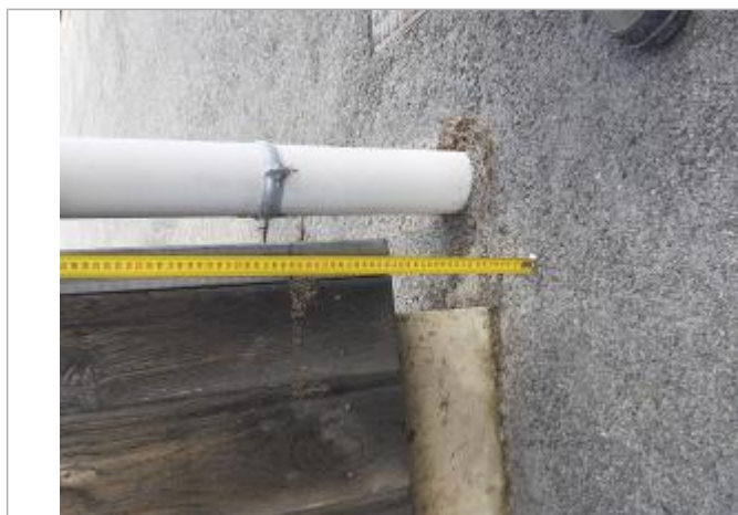
Trace au marqueur 34 cm du sol
