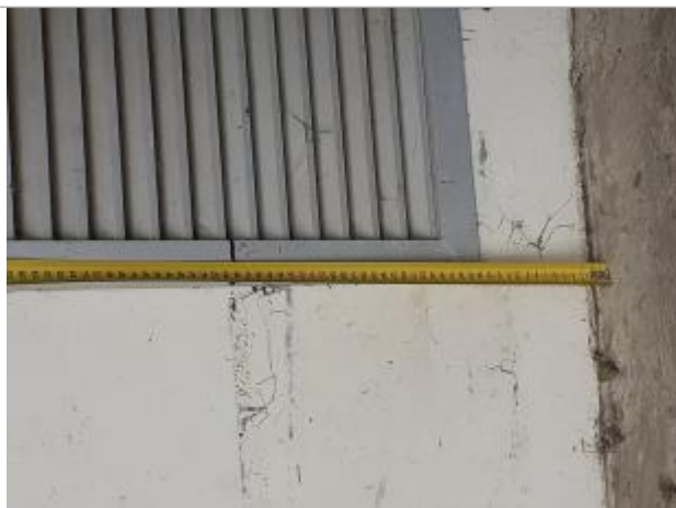
Trace sur la grille et dépôt sur le mur.
