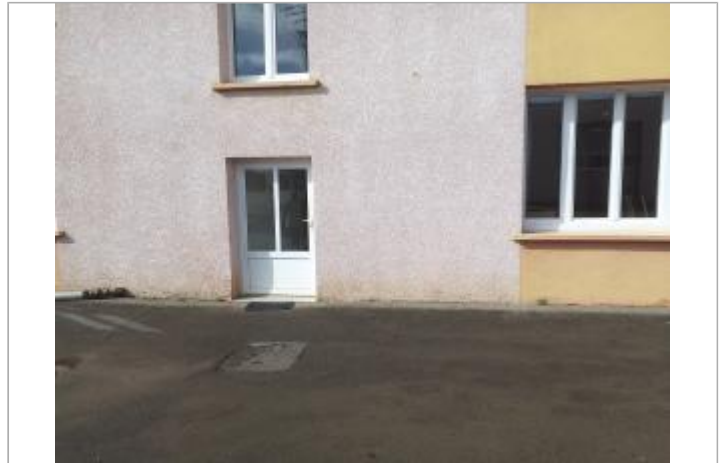
Point d'accueil de jour - entrée arrière du bâtiment
