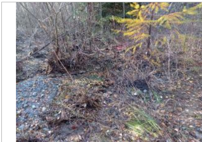
Vue générale du site. Photo © AGERIN 2023
