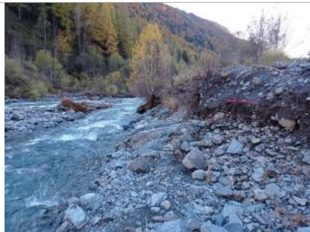
Vue générale du site. Photo © AGERIN 2023
