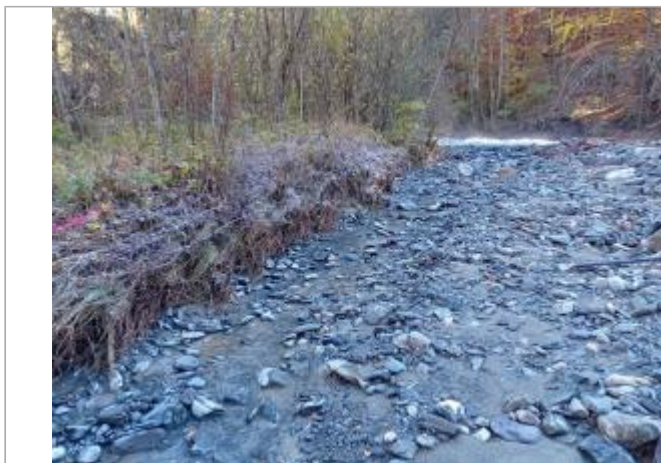
Vue générale du site. Photo © AGERIN 2023
