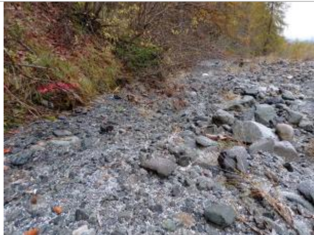
Vue générale du site. Photo © AGERIN 2023
