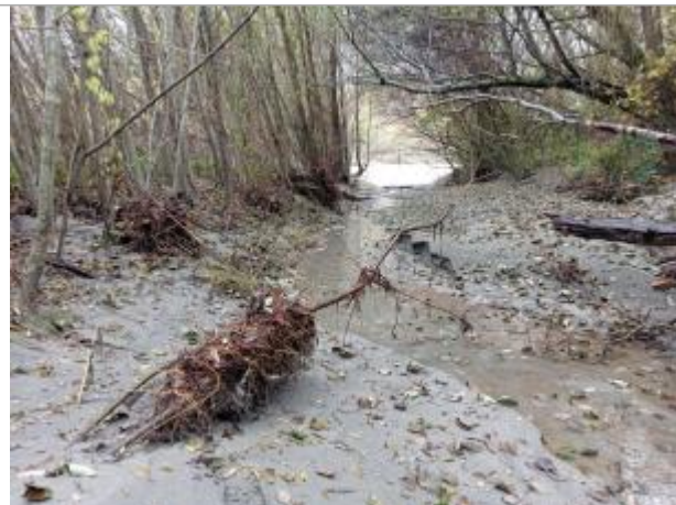
Vue générale du site. Photo © AGERIN 2023
