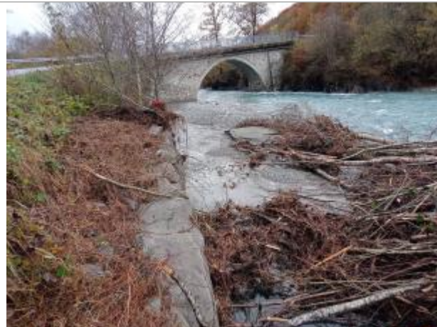
Vue générale du site. Photo © AGERIN 2023
