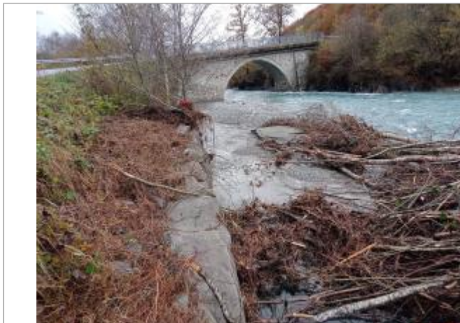
Vue générale du site. Photo © AGERIN 2023
