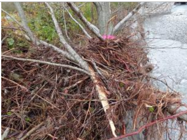
Vue rapprochée du repère. Photo © AGERIN 2023
