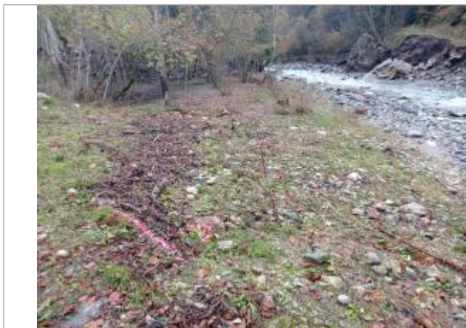
Vue générale du site. Photo © AGERIN 2023
