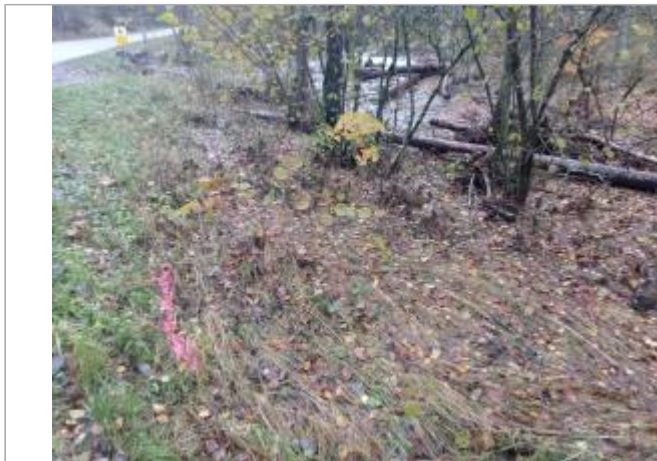
Vue générale du site. Photo © AGERIN 2023
