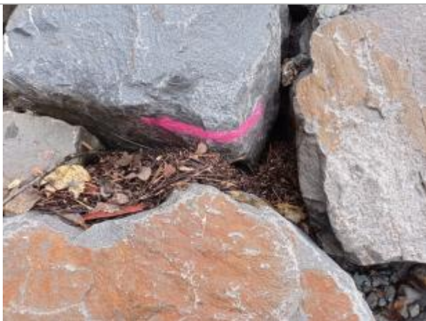
Vue rapprochée du repère. Photo © AGERIN 2023
