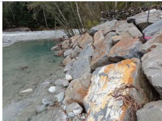
Vue générale du site. Photo © AGERIN 2023
