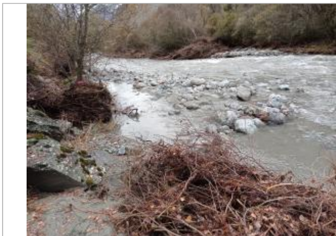
Vue générale du site. Photo © AGERIN 2023
