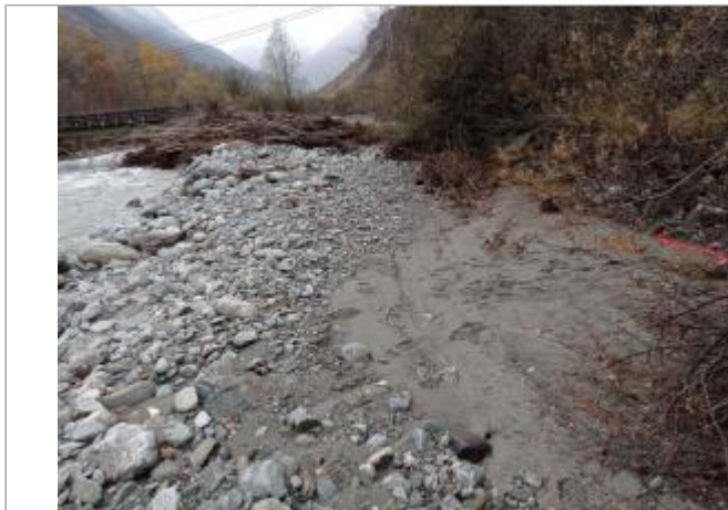
Vue générale du site. Photo © AGERIN 2023
