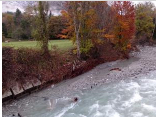
Vue générale du site. Photo © AGERIN 2023
