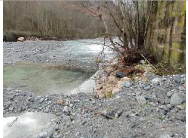
Vue générale du site. Photo © AGERIN 2023
