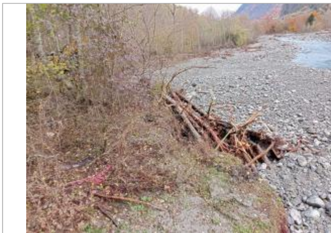
Vue générale du site. Photo © AGERIN 2023
