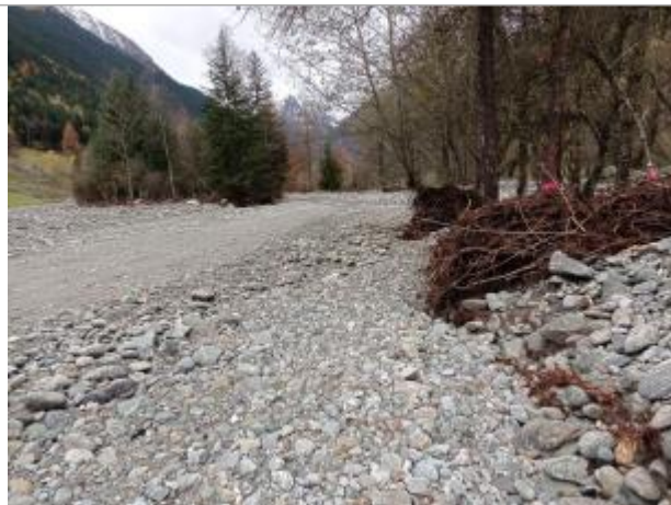
Vue générale du site. Photo © AGERIN 2023
