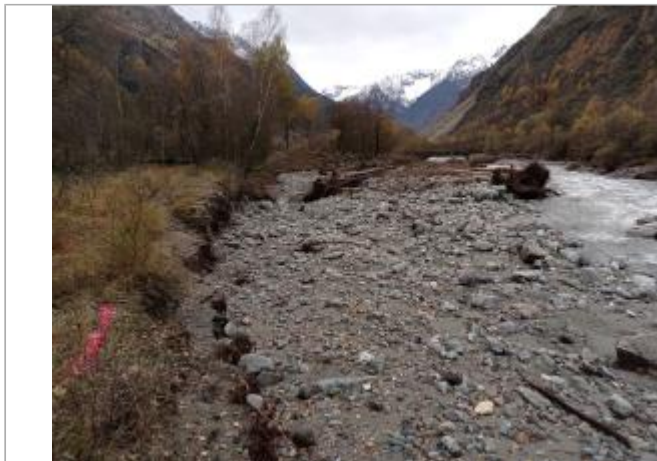
Vue générale du site. Photo © AGERIN 2023
