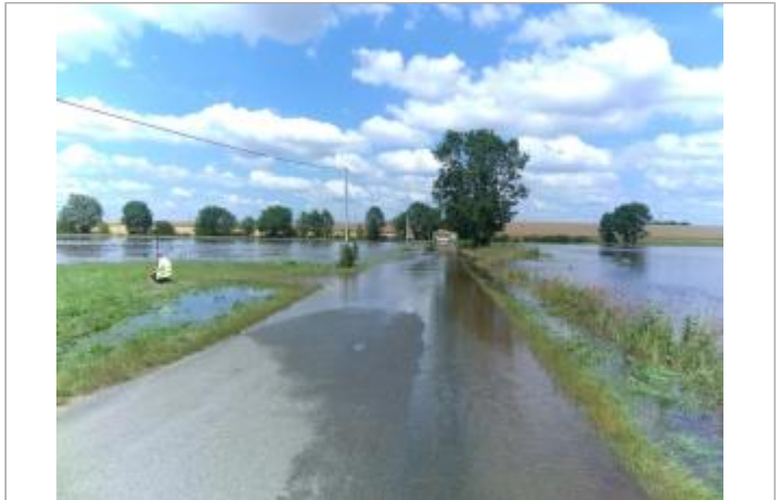
Vue du site, le 24/06/2024, SPC LACI
