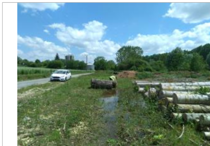
Vue du repère, le 24/06/2024, SPC LACI
