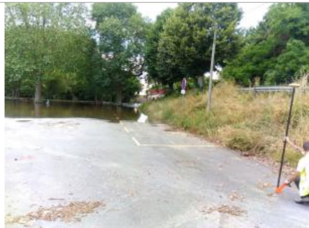
Vue du site, le 24/06/2024, SPC LACI
