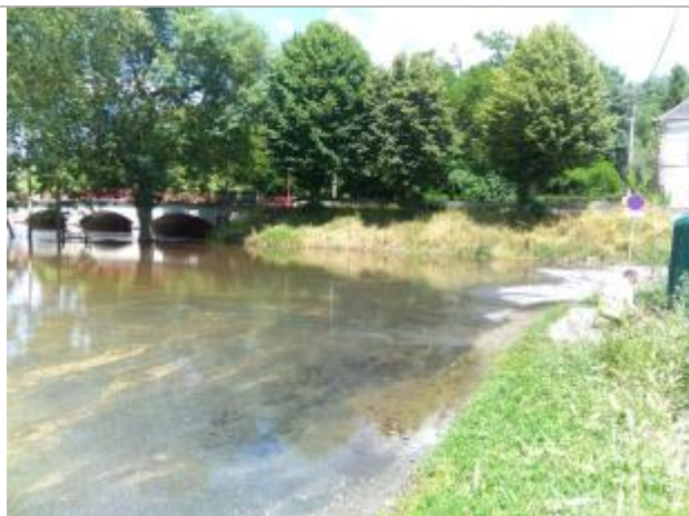
Vue du repère, le 24/06/2024, SPC LACI
