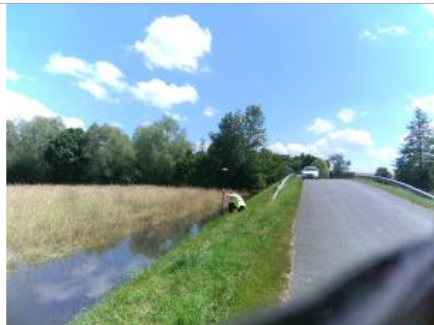
Vue du site, le 24/06/2024, SPC LACI
