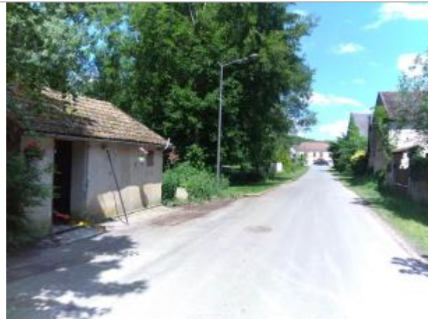
Vue du site, le 24/06/2024, SPC LACI
