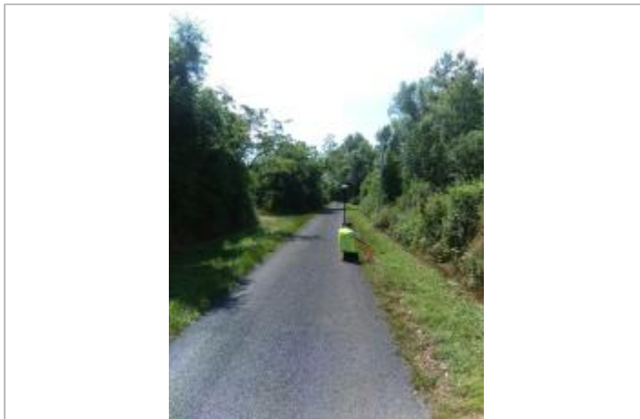
Vue du site, le 24/06/2024, SPC LACI
