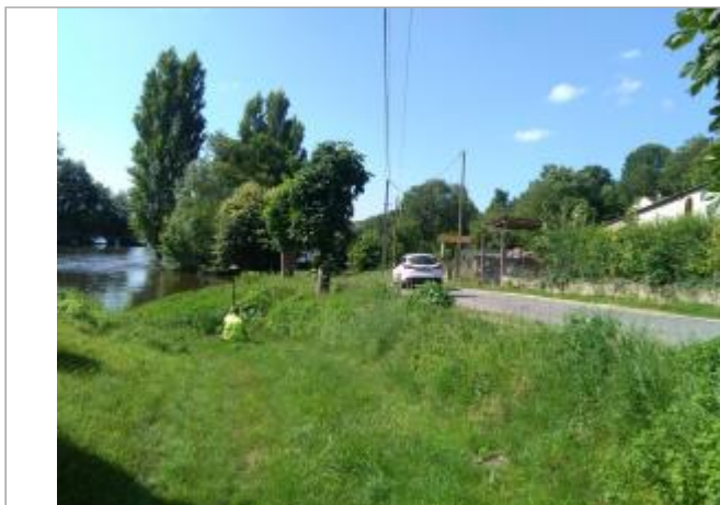
Vue du site, le 24/06/2024, SPC LACI
