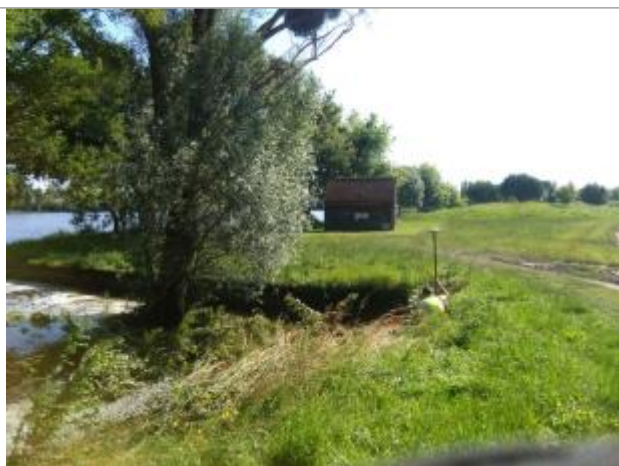
Vue du repère, le 24/06/2024, SPC LACI
