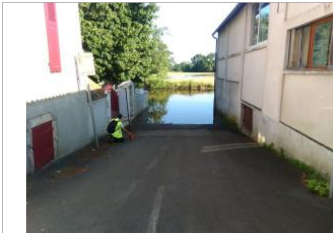
Vue du site, le 24/06/2024, SPC LACI
