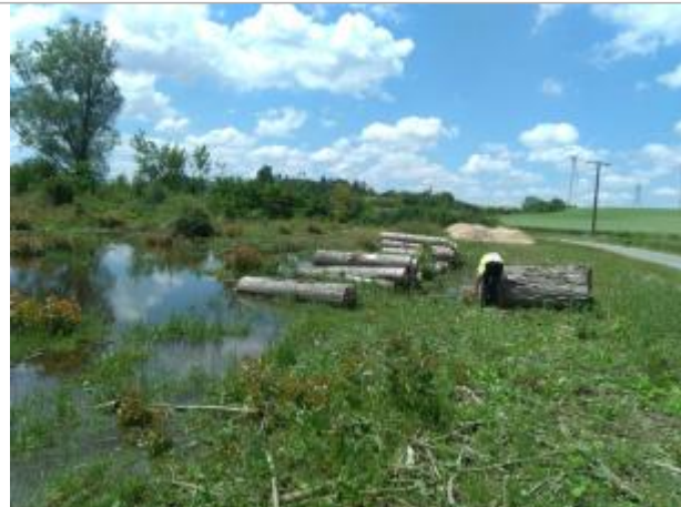
Vue du site, le 24/06/2024, SPC LACI
