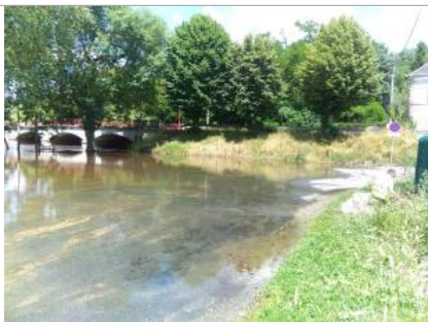
Vue du repère, le 24/06/2024, SPC LACI
