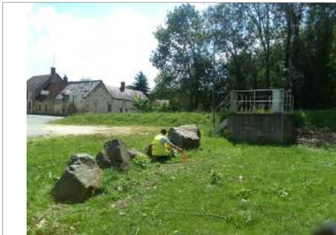
Vue du site, le 24/06/2024, SPC LACI
