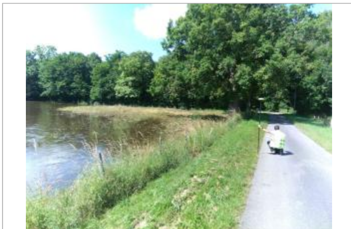
Vue du site, le 24/06/2024, SPC LACI
