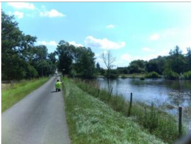
Vue du repère, le 24/06/2024, SPC LACI
