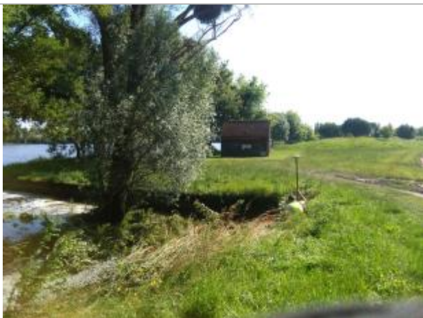
Vue du repère, le 24/06/2024, SPC LACI
