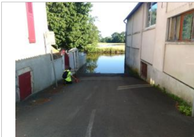
Vue du site, le 24/06/2024, SPC LACI
